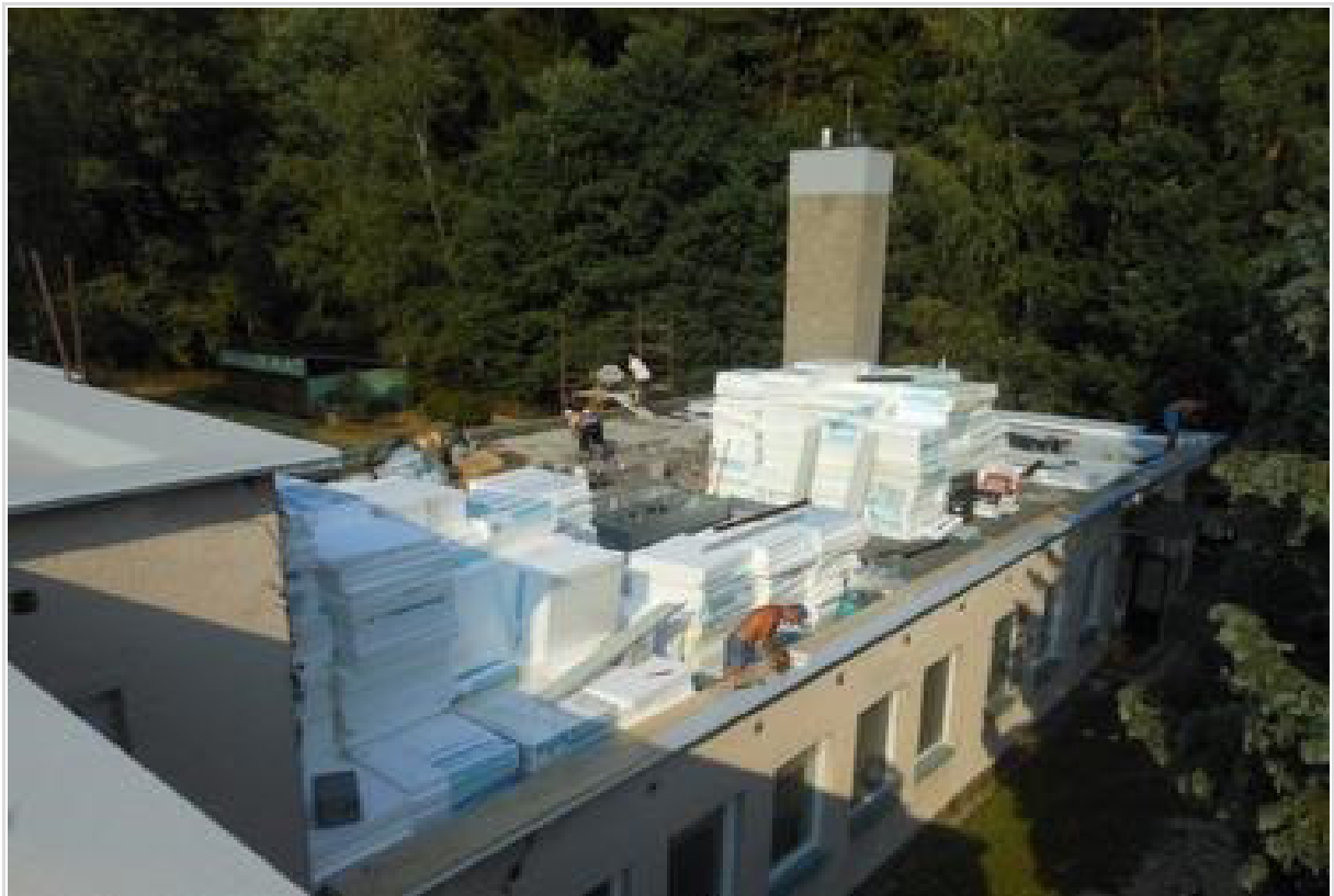
Obr. 8: zateplování střech
